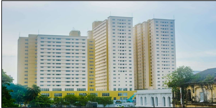
කොළඹ 02, කොම්පක්ස්විදියේ ප්‍රතිසංවර්ධන ව්‍යාපෘතිය - පළමු අදියර Re Development Project - Stage1 at Slave Island, Colombo 02 (Category I - Value above Rs: 750 M) ආර්. එන්. කන්ස්ට්‍රක්ෂන්ස් (පුද්ගලික) සමාගම R N Constructions (Pvt) Ltd
